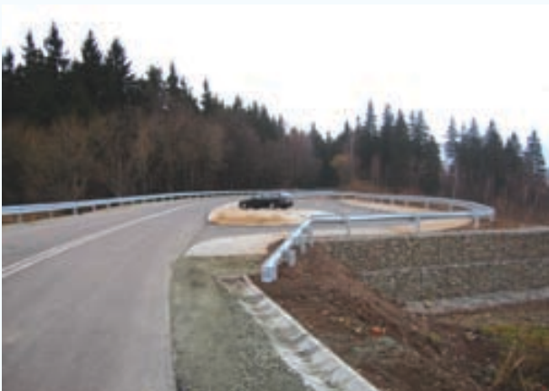
Przebudowa drogi wojewódzkiej nr 389 na odcinku 11,2 km Duszniki Zdrój – Zieloniec
