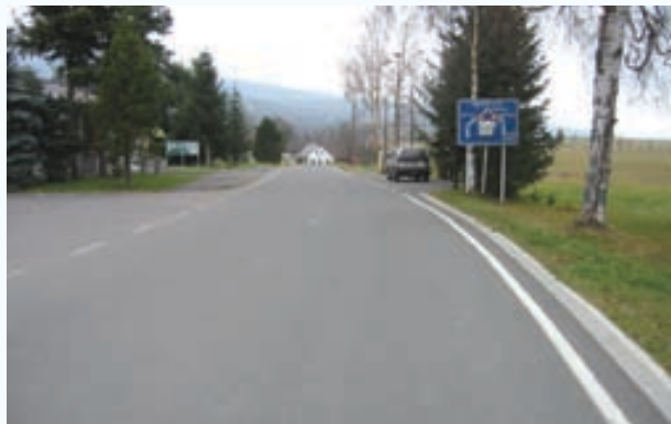
Orlické Záhoří – Modernizacja drogi II/311
